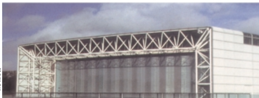
Norwich-eko Ikusezko Arteen Sainsbury Zentroak 7,30 m altu eta 29 m zabal den beirazko horma du. Bertan, panelak soilik erabiltzen dira espazioa banatzeko.
