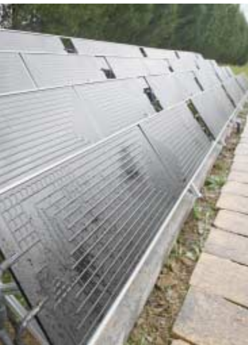
Eguzki-panel termodinamikoan instalazioen desabantaila da toki handia behar dutela.
